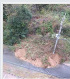
土砂崩れの様子 ▲
