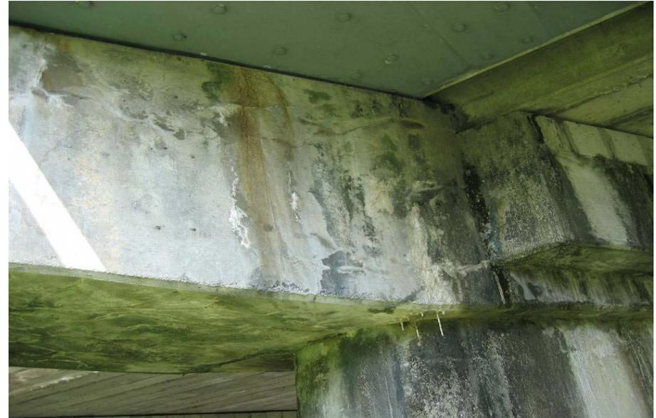
応力度方向のひび割れ
