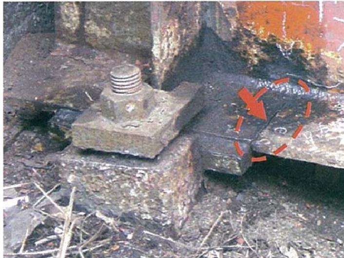
主桁下フランジの疲労亀裂
