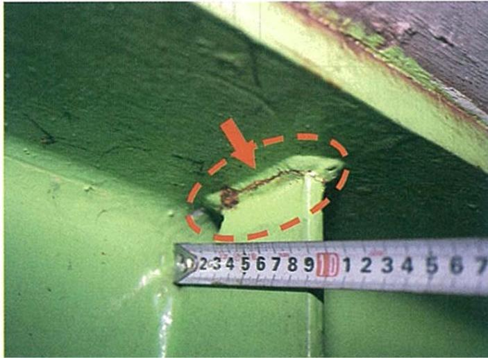
垂直補剛材の疲労亀裂
