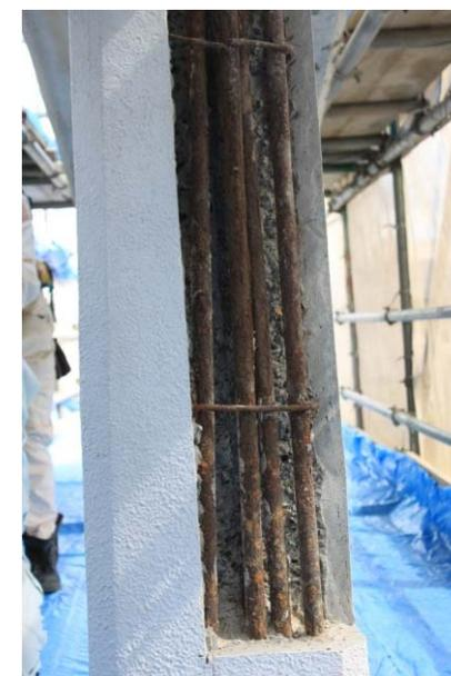
鉄筋腐食状況
