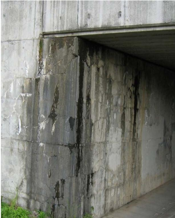
反応性鉱物とアルカリが反応しアルカリシリカゲルが作られ、それが吸水し膨張する。この膨張圧によりコンクリートにひび割れが発生する。
