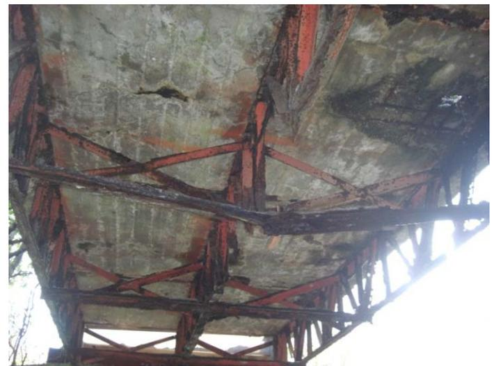
床板下面の損傷
