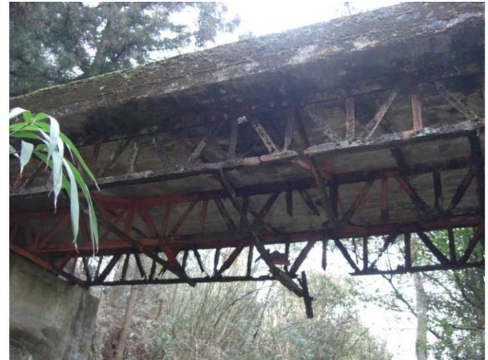
トラス部材の破断
