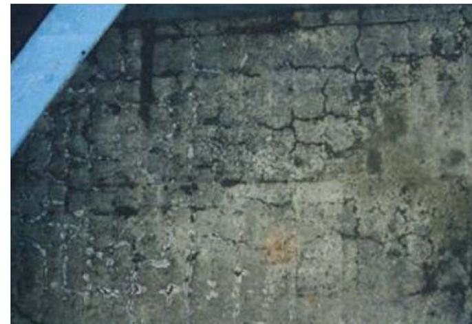
損傷床板下面
