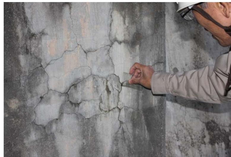
ひび割れ幅計測
