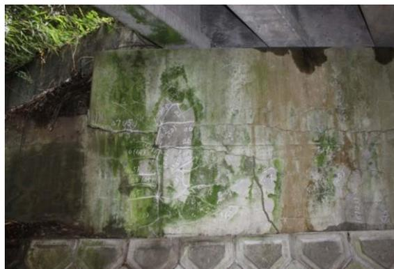
綾上地区ASR損傷橋台5橋
