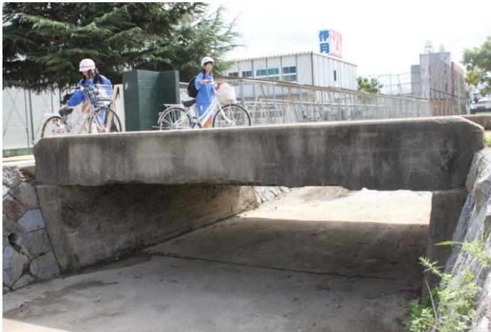
主筋・配力筋ともに鉄筋は1段配置となっており、鉄筋が露出しコンクリートとの一体化が損なわれると橋の耐荷性能が極端に低下する。
