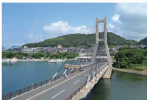
図5 ケーブル系PC斜張橋
