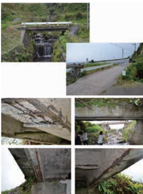
図26 老朽化した橋梁の状況
