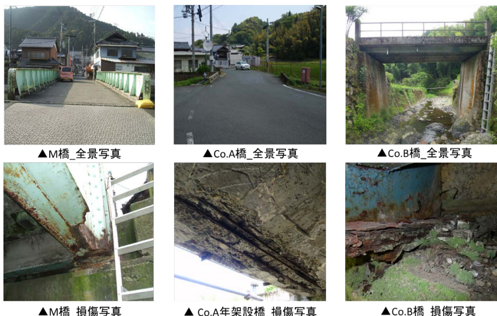
図3. 1 橋梁の劣化損傷事例
