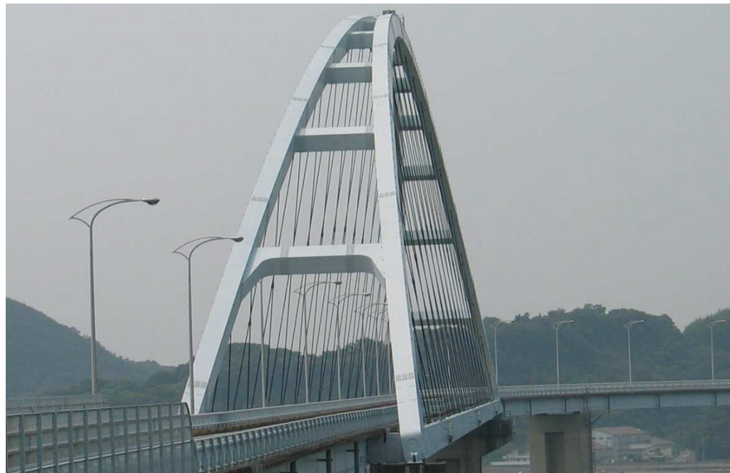
内海大橋（広島県）
