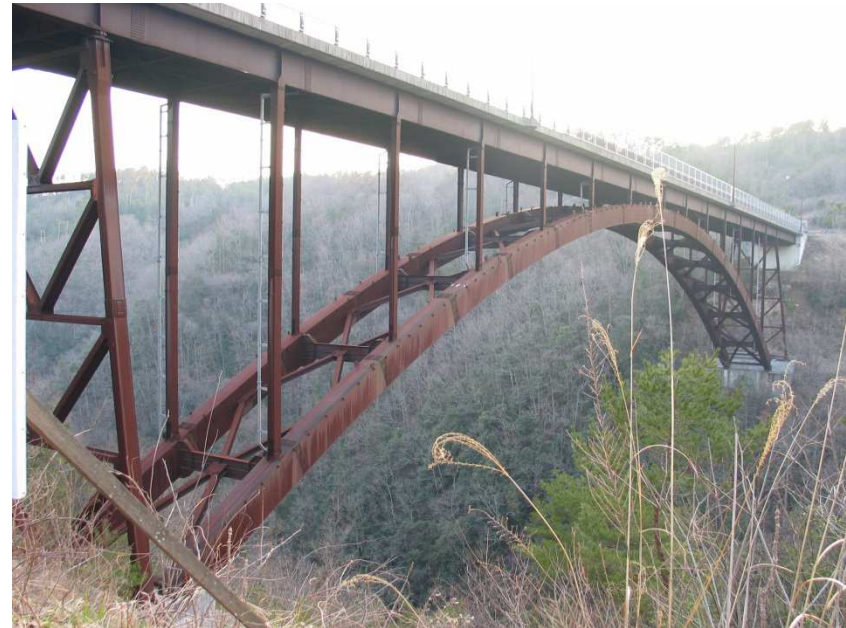
松岡大橋（岡山県）
