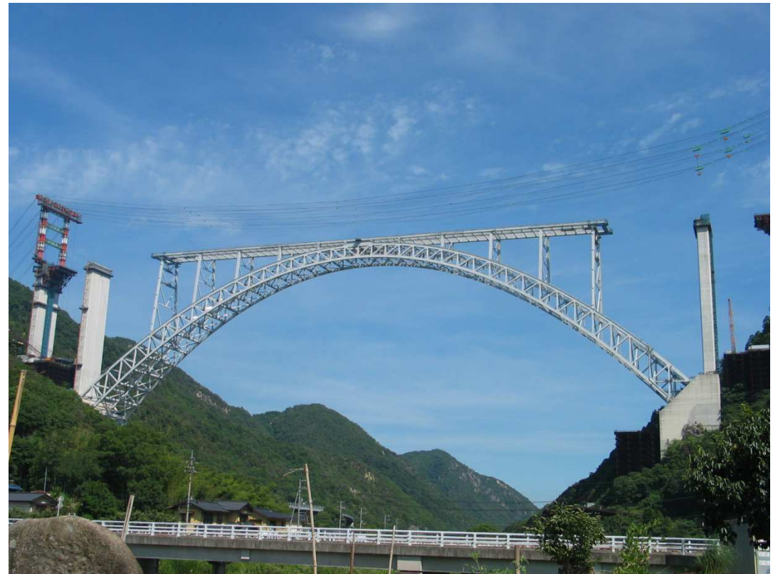
広島空港大橋（広島県）
