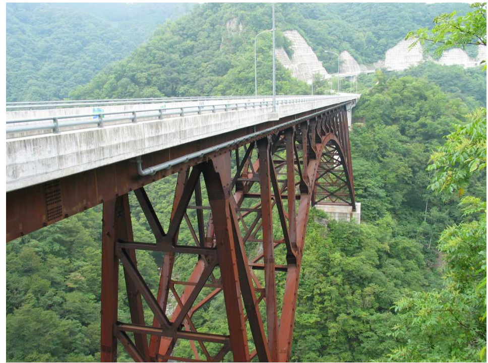
福柵川橋（広島県）
