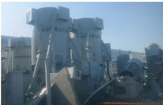
図3 津波で機能を喪失した海水系ポンプ
