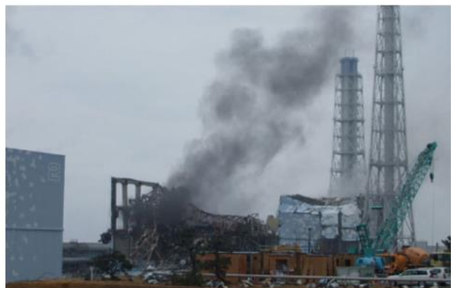
図4 水素爆発後の3号機原子炉建屋
