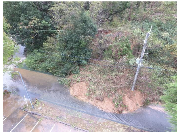
写真-2 被害の様子 崩壊土砂が流路をふさいで水があふれている様子
