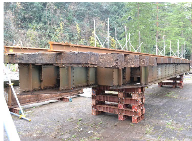
鉄道橋(提供:えちぜん鉄道)
