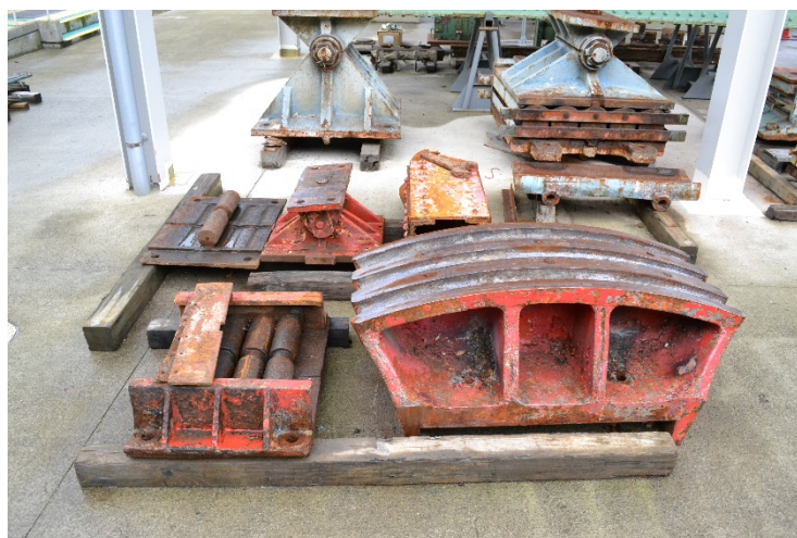
吊橋サドル部, ケーブル定着部(提供:浜松市)
