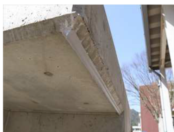
写真-7 水切りモデル (左: Vカット, 右: 後付け型水切り)
