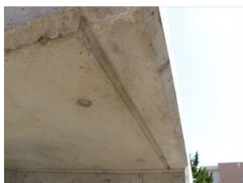
写真-7 水切りモデル (左: Vカット, 右: 後付け型水切り)
