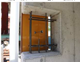
写真-6 配筋, 型枠観察箇所
