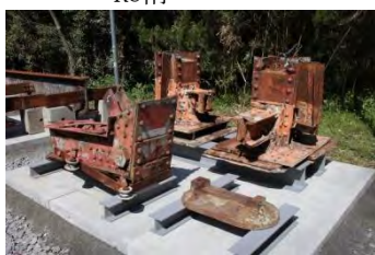
トラス格点・支承，線支承
