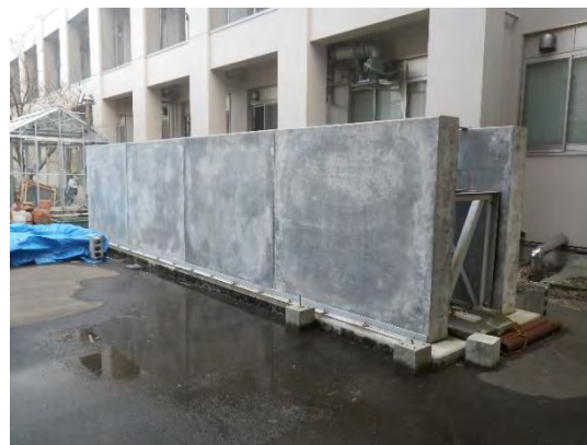
写真3. 13 初期欠陥試験体（既存施設）
