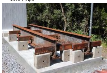
リベット桁（1/2切筋）
