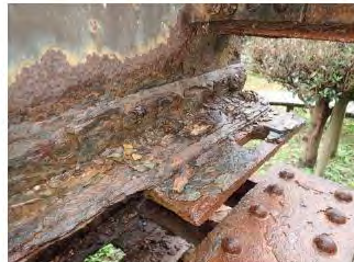
図3. 4 実物劣化教材: 鋼リベット桁
