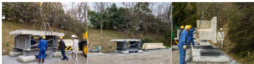
RC床版据付け
