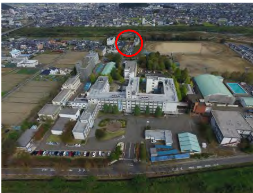
写真3. 16 福井高専の全景と環境都市工学科棟の位置
