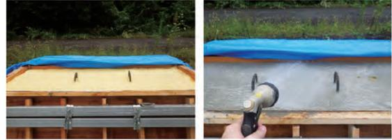
型枠脱型（4日目） 打設から2週間後
