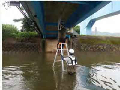
市場795歩道橋 定期点検状況(参考)
