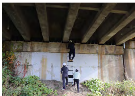
(D) 第2回 鯖江大橋の支承等の近接目視
