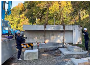
写真 3.5.2 同 撤去搬出状況
