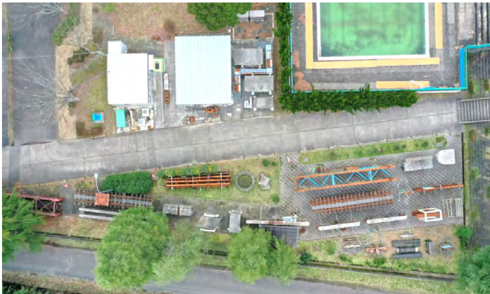
写真 3.4.1 実習フィールド 全景
