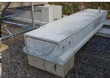
写真 3.5.8 PCスラブ桁
