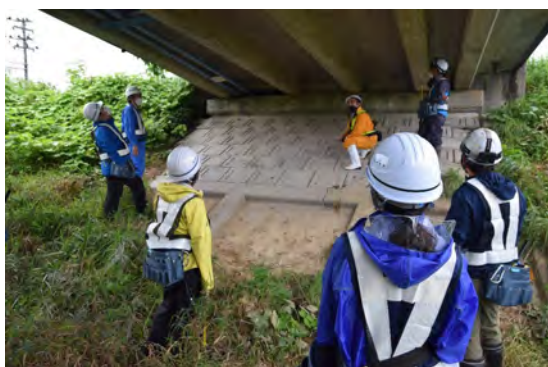
写真 3.1.10 現場実習（飯崎橋）
