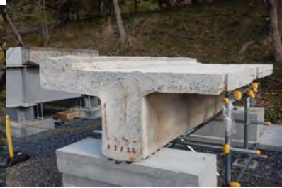
写真 3.5.6 七間橋RC桁
