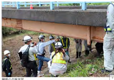
鋼橋の点検実習
