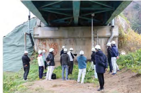
橋座付近：点検支援ロボット(高所型)
