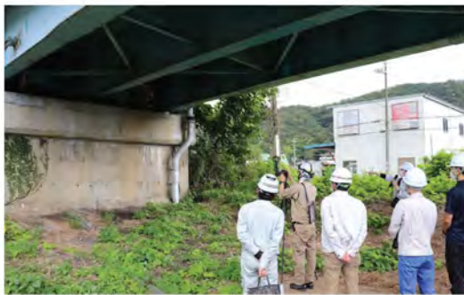
縦壁：ひびわれの画像判読／近接目視確認
