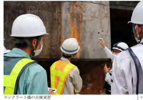
コンクリート橋の点検実習
