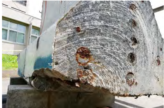
写真 3.2.2 塩害を受けたポストテンション方式 T 桁
