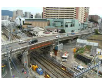
写真 3.5.1 麦野跨線橋供用時
