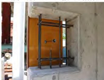
写真-6 配筋, 型枠観察箇所
