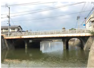
写真 3.5.4 七間橋供用時
