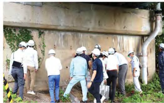
縦壁：ひびわれの画像判読／近接目視確認
