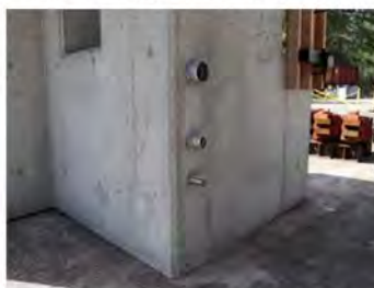
写真-8 シース管, PC 鋼棒
