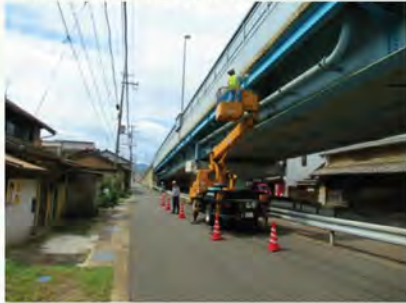
青葉大橋 定期点検状況(参考)
