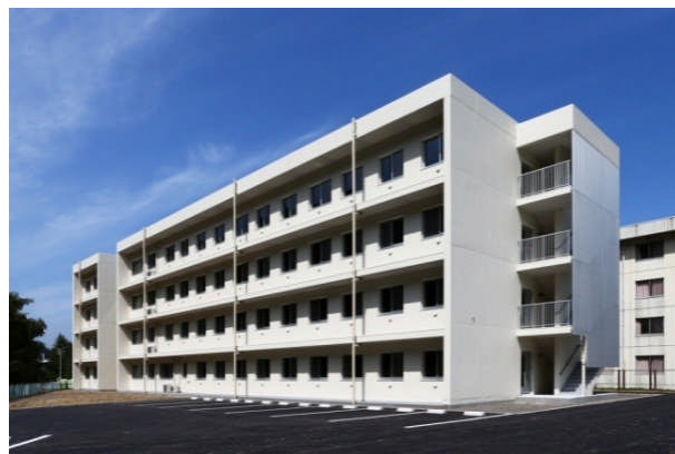
寄宿舍 7 号館 南面
