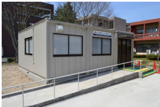
橋梁実験室 外観
