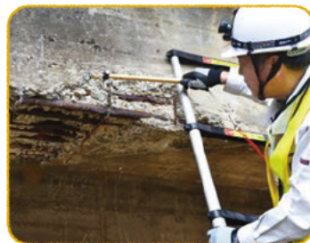
舞鶴市内の相生橋での点検実習
