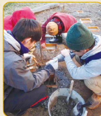
基礎打設風景
