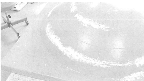
Fig. 6 表面の凸凹をシリコン系パテにて修正
