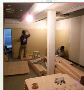
内装工事奮闘中
