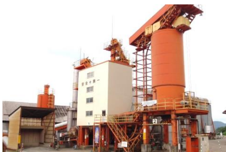
アスファルト合材工場
