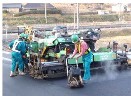
合材舗設作業
