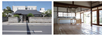
左/建物の外観は活かして改修 右/居間2間の敷居を無くし縁側に面したリビングダイニングに
