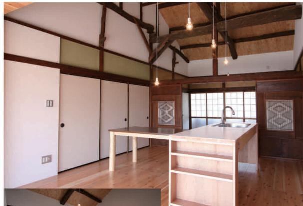
上/和室2間の間にあった鴨居の上の壁を撤去して広々とした空間に 左/玄関に土間を作り、箱窓のある客間も設けた
