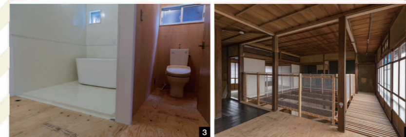
1 2階の床を撤去して吹き抜けにした、地域の人を招いたり子どもが遊べる「ソト」と位置づけた空間 2 2階部分には窓の開閉や掃除をしやすいようにキャットウォークを設置。ネットも貼り、楽しい遊び場のような雰囲気 3 トイレやお風呂はモダンに。改修のポイント是对象となる住宅によってさまざま(写真はすべてお試し住宅第5号)
