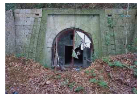
写真3 第4トンネル 東側坑門
