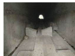
写真7 トンネル内部 (第3トンネル)
