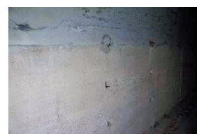
写真9 側壁にある穴
