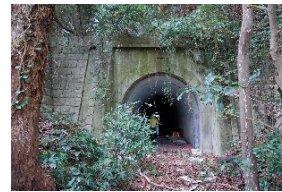
写真1 第1トンネル 東側坑門
