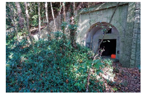
写真2 第1トンネル 西側坑門
