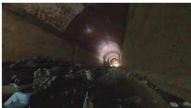
写真 18 第 4 トンネルの 360°画像
