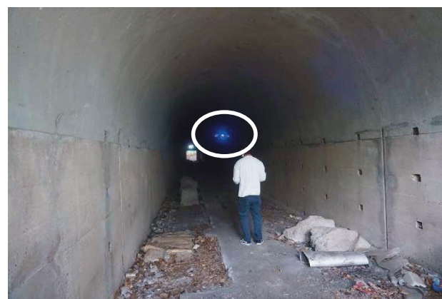
写真 15 UAV 飛行状況（第 1 トンネル）
