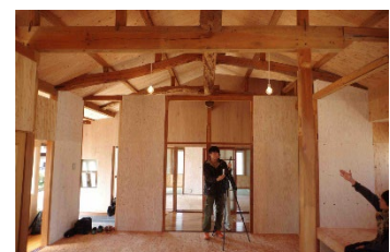
空き屋改修-移住者促進住宅
