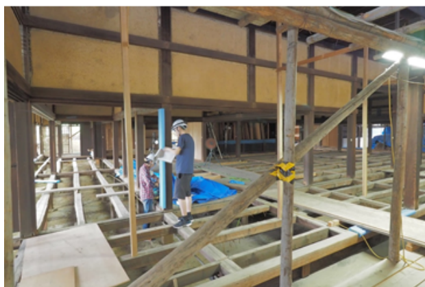
文化財建物の調査風景
