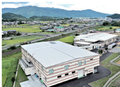
2020年 八木第二工場が竣工
