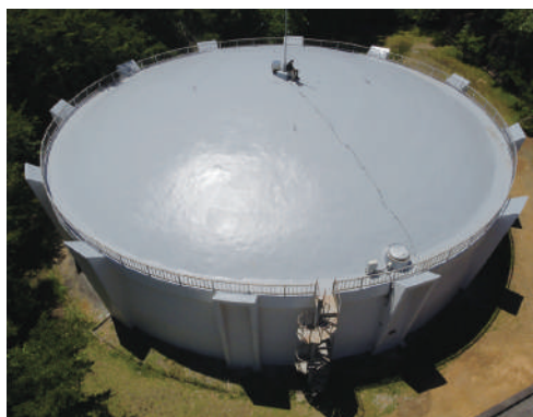
高区配水池改修工事
