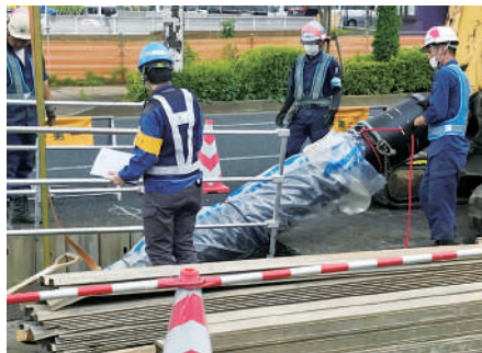
管路工事監督業務
