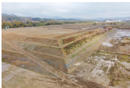
弘法川床上浸水対策特別緊急工事
