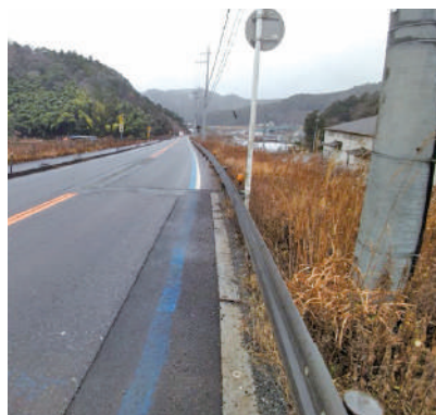
国道 175 号 防災・防雪対策工事
