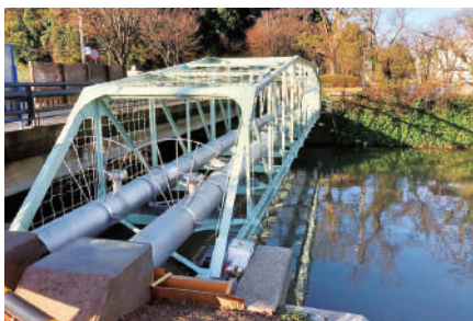
夕潮橋 水管橋架設替工事
