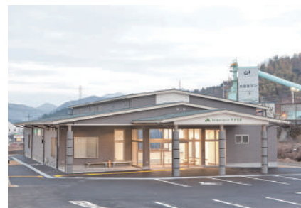
セレモニーホール新築工事
