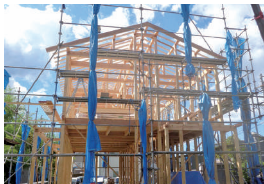
・新築工事/上棟式
